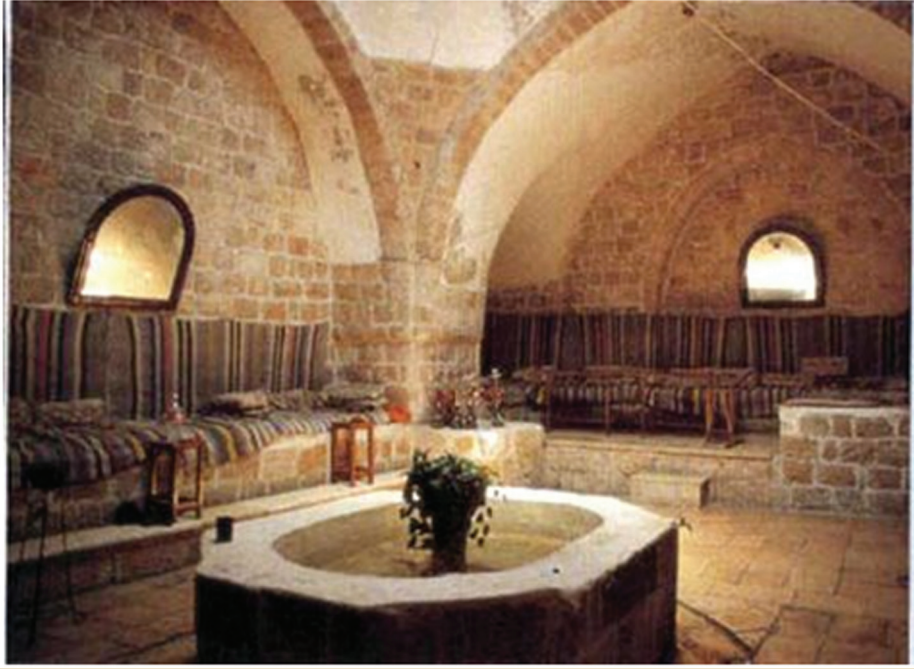
لوحة رقم (5) حمام الشفاء : أرجل العقود والمثلثات الكروية الحاملة للقبّة .
